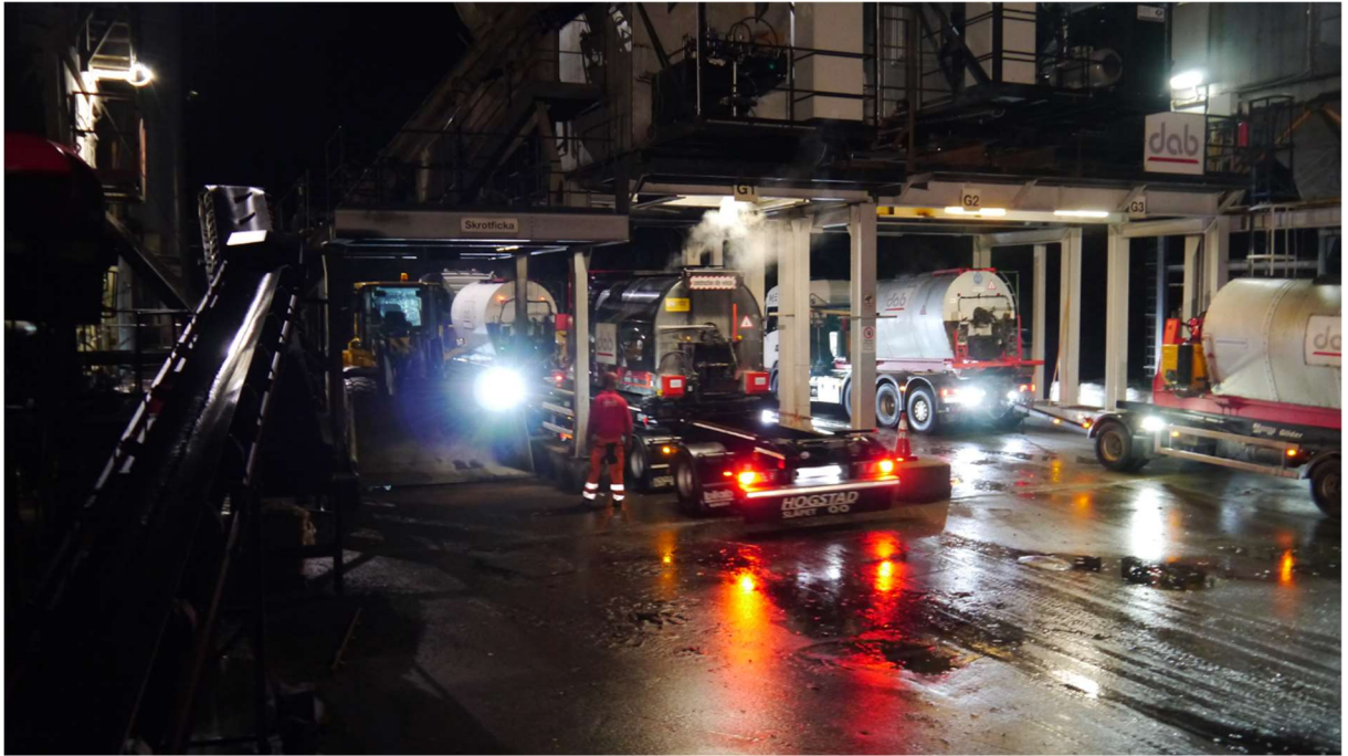
Bild 32, Gjutasfaltbilar ska lastas inför transport till arbetsplatsen.
