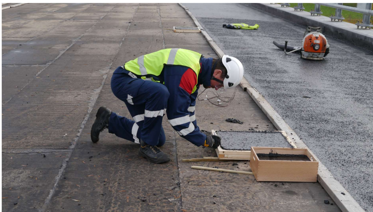
Bild 46, Temperaturmätning av gjutasfalt med magnetit på E6 Nordreälvbron
