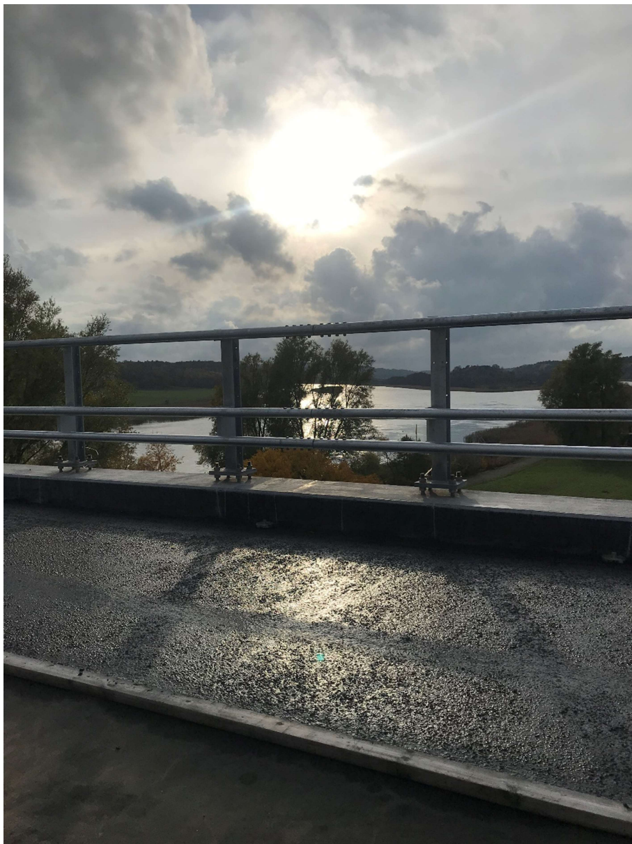
Bild 38, Arbetsplatsen på E6 Nordreälvbron
