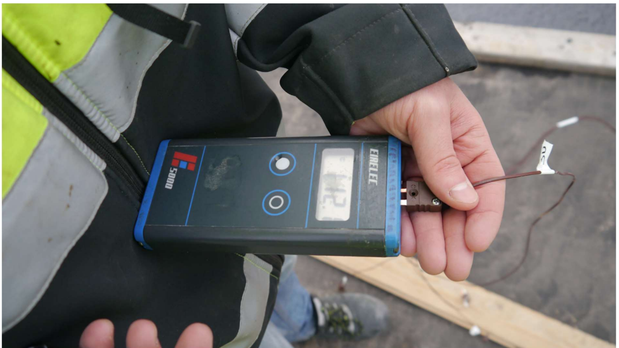
Bild 49, Temperaturmätning av gjutasfalt med magnetit på E6
