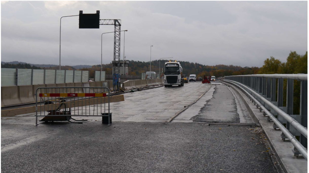
Bild 36, Arbetsplatsen på E6 Nordreälvbron
