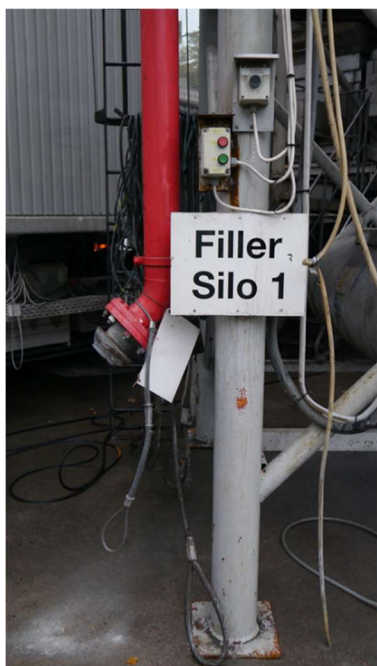
Bild 22-24, Inmatningen av magnetit via t.ex. fillertorn rekommenderas för förvaring av magnetit.
