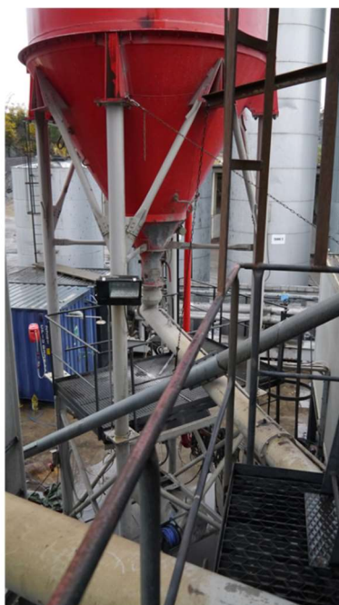
Bild 22-24, Inmatningen av magnetit via t.ex. fillertorn rekommenderas för förvaring av magnetit.
