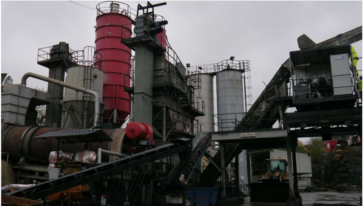
Bild 26, DABs anläggning i Kungälv
