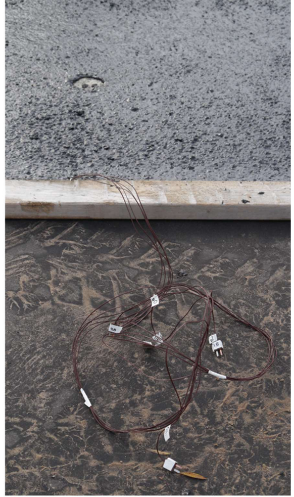
Bild 47-48, Temperaturmätning av gjutasfalt med magnetit på E6 Nordreälvbron
