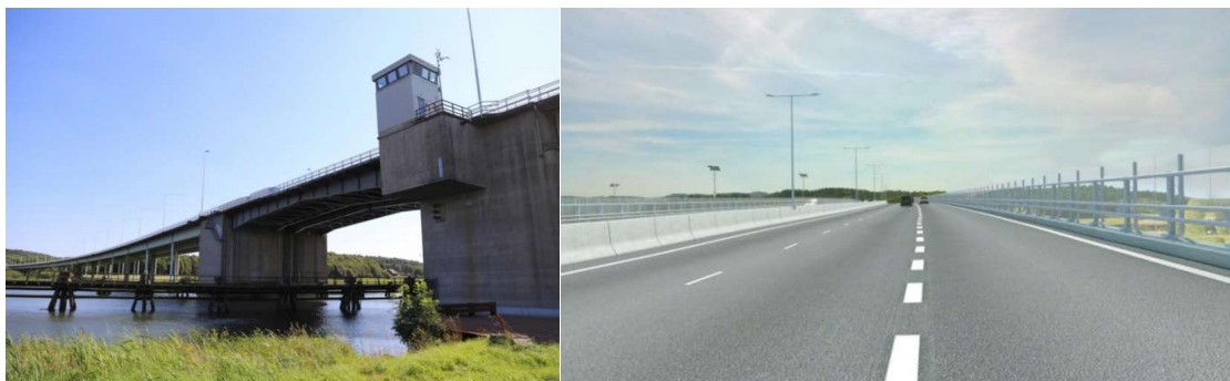
Bild 12 och 13: Nordreälvbron vid Kungälv.
