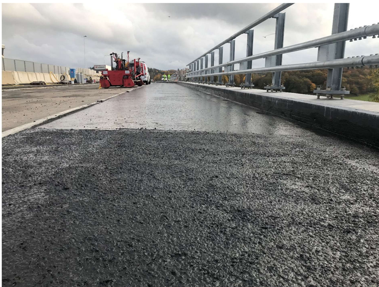
Bild 44-45, Ytan på gjutasfalt med magnetit på E6 Nordreälvbron
