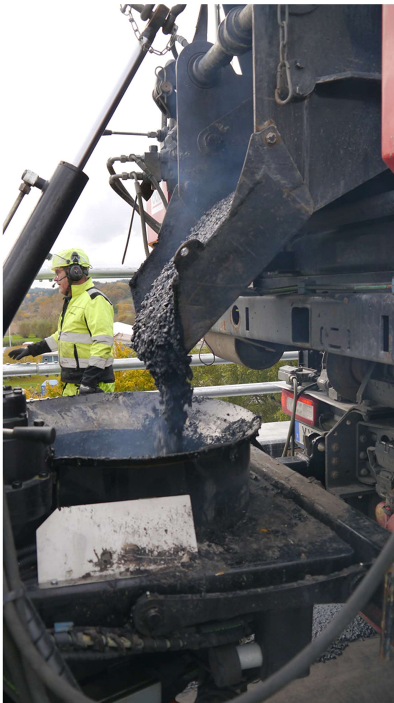
Bild 43, Påfyllnad av gjutasfalt med magnetit på E6 Nordreälvbron
