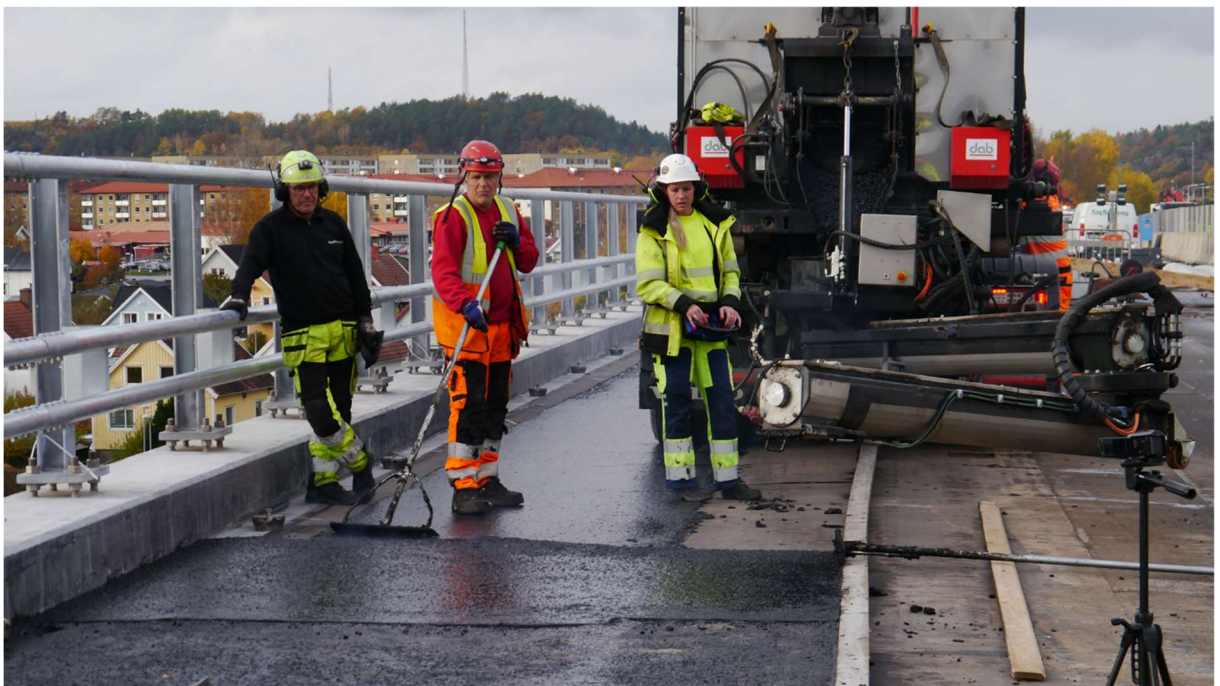
Bild 42, Läggnig av gjutasfalt med magnetit på E6 Nordreälvbron
