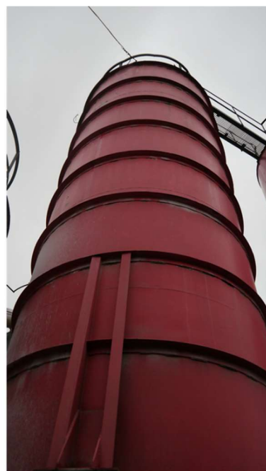
Bild 22-24, Inmatningen av magnetit via t.ex. fillertorn rekommenderas för förvaring av magnetit.
