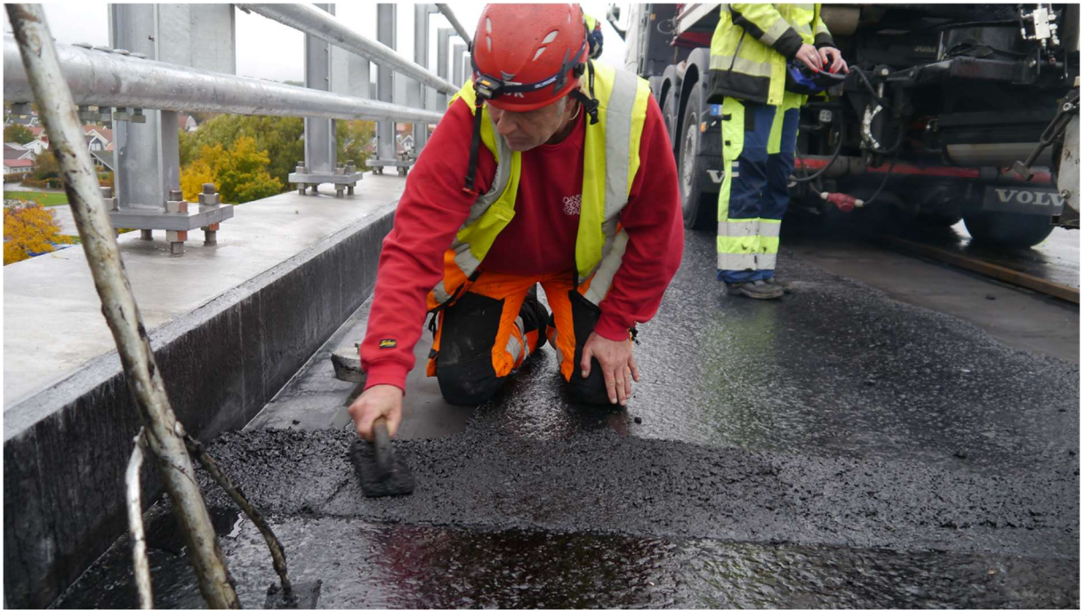
Bild 41, Läggnig av gjutasfalt med magnetit på E6 Nordreälvbron
